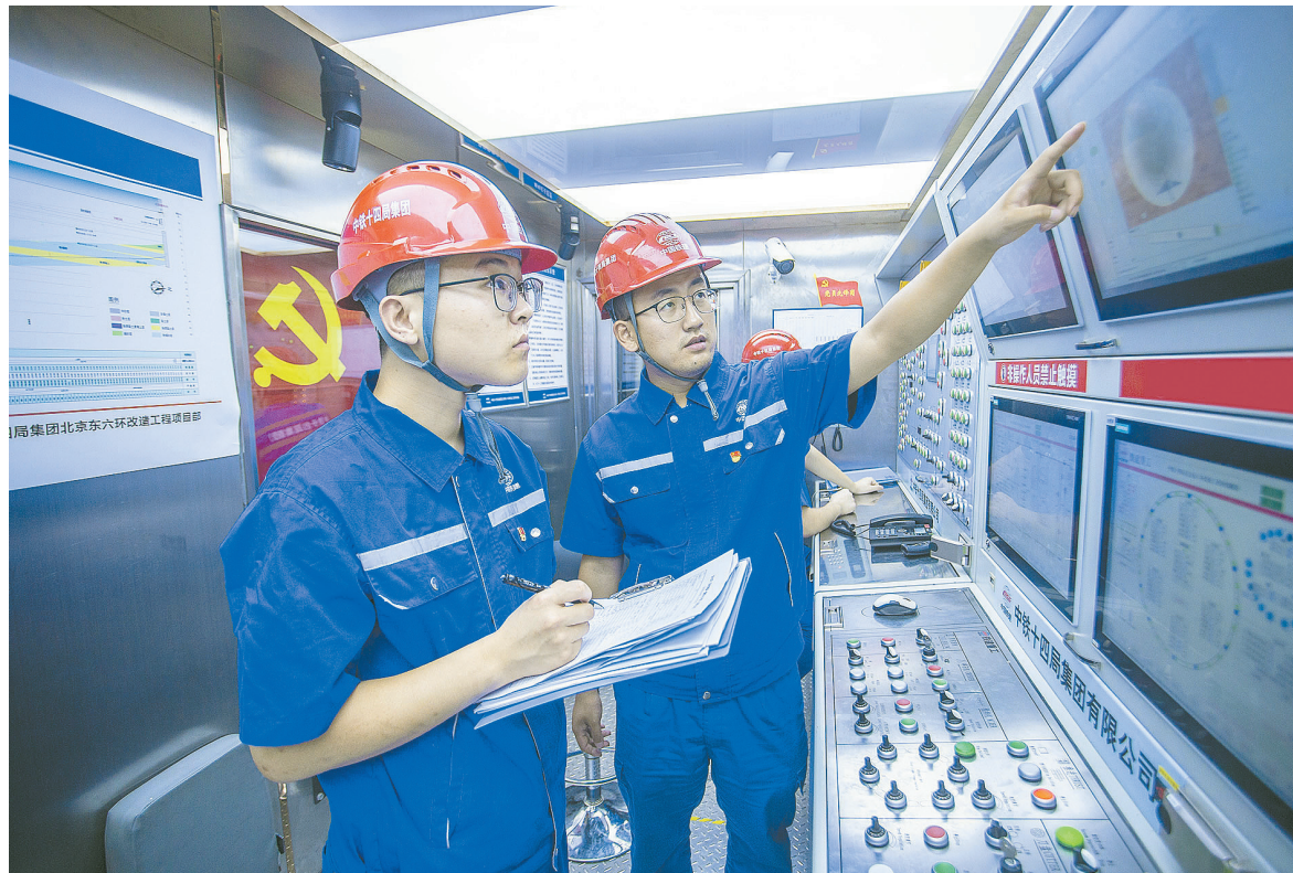
日前,在中铁十四局承建的北京东六环改造项目,国产最大直径盾构机“京华号”正在穿越北京城区,进入常态化掘进施工。这里不仅是大盾构施工前沿技术的实操之地,更是大盾构人才的培养基地。图为在该项目开展的导师带徒活动中,盾构副经理孙长松正在给徒弟王虎然讲解盾构机掘进参数。
