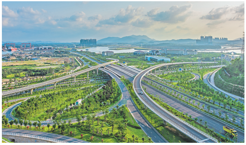
平潭综合实验区坛西大道渔平互通立交桥。
