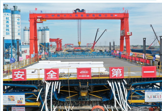
杭甬复线宁波一期项目浇筑首片梁。
