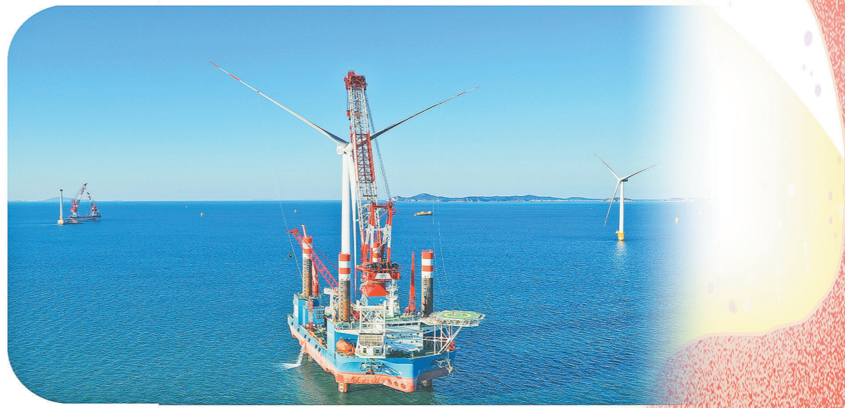
大连庄河海上风电项目“双舰合璧”,进行风机安装
