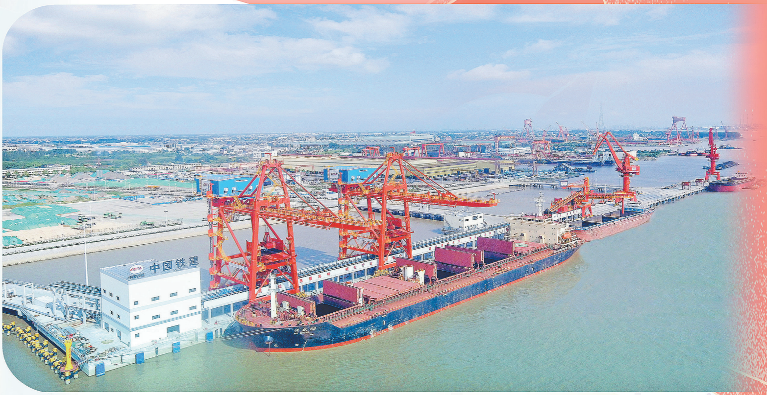
中国铁建首个投资建设并运营的港口码头——泰兴七圩公用码头
