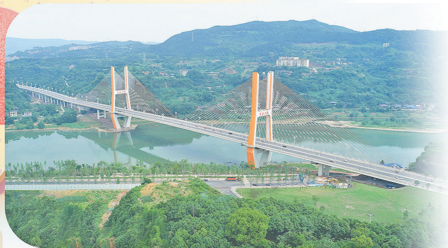
中国铁建港航局投资建设并获得国家优质工程奖的达州金南大桥
