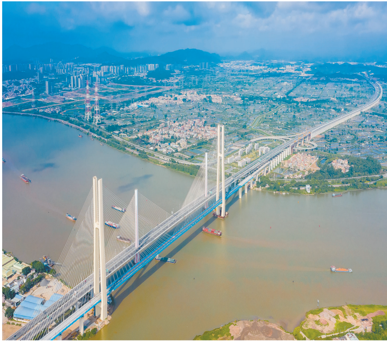
7月28日,由中铁十一局承建的粤港澳大湾区基础设施重点工程——广州南沙港铁路跨西江斜拉桥全部完工,为工程如期建成通车奠定了基础。该桥位于广东佛山市和江门市交界处,全长1117.5米,其中主跨跨径600米,是目前世界双钱钢架铁路建设史上同类型结构跨度最大的斜拉桥。图为建设中的南沙港铁路跨西江斜拉桥。
