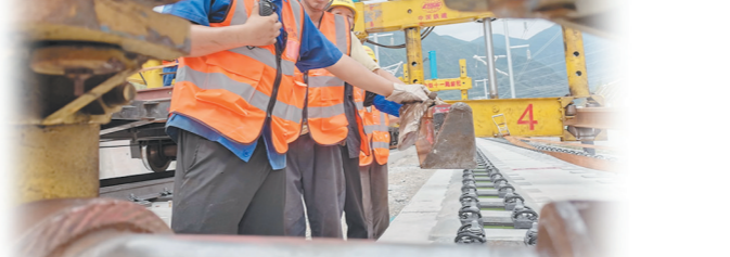
图为施工人员引导钢轨穿进本邻两线铺轨设备。 庞 军 摄
