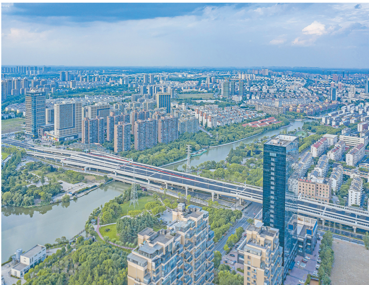
日前,由中铁二十局参建的嘉兴市首条快速路环线工程正式通车。该工程全长28.67公里,是嘉兴快速路网“一环七射”总体布局中的“一环”,也是嘉兴市“十大标志性工程”之一。工程建成通车后,将进一步完善嘉兴区域一体化交通体系,助力嘉兴市成为具有国际化品质的现代化网络型田园城市。图为建成通车后的嘉兴市快速路环线。
