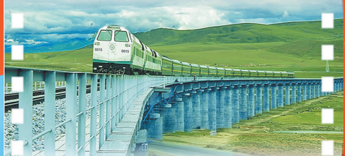
2006年7月1日,成功解决了“多年冻土、高寒缺氧、生态脆弱”三大世界级难题,世界上海拔最高的高原铁路——青藏铁路建成通车。中国铁建承担了全线全部的勘察设计任务,72%的路段和所有海拔4900米以上越岭地段的施工任务。
