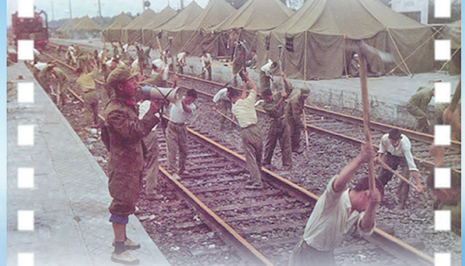
1976年7月28日3时42分,唐山发生里氏7.8级大地震。铁道兵第一时间进入重灾区,10天抢救唐山、通坨铁路,及时运出伤员,运进大批救灾物资。图为铁道兵第14师68团紧急抢修唐山车站。
