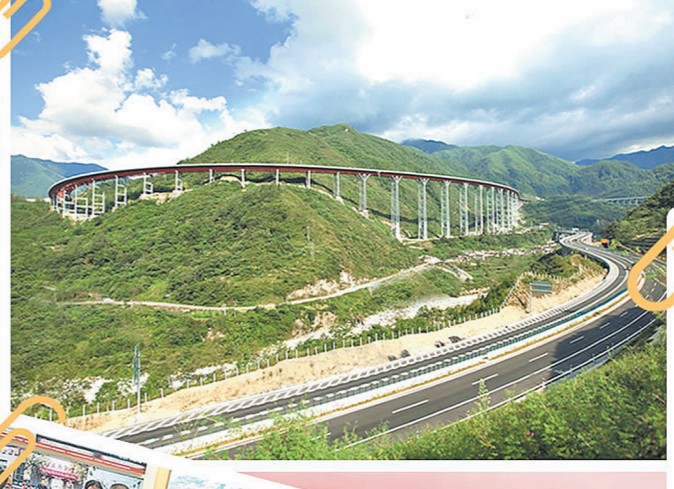
2012年4月28日,雅西高速公路干海子特大桥建成通车。由中铁二十三局承建的干海子特大桥是交通部科技示范项目,是雅西高速重(难)点控制性工程。大桥全长1811米,共36跨,采用设计新颖的全钢管(混凝土)桁架连续梁结构,建设者在施工中创下同类桥梁施工史上4项之最。 马鹏飞 摄
