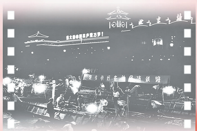
1965年7月1日,由铁道兵参加修建的北京地铁破土动工。北京地铁是中国自行设计、自行施工的第一条地下铁道。图为施工部队日夜奋战,在北京站前修建地铁车站。
