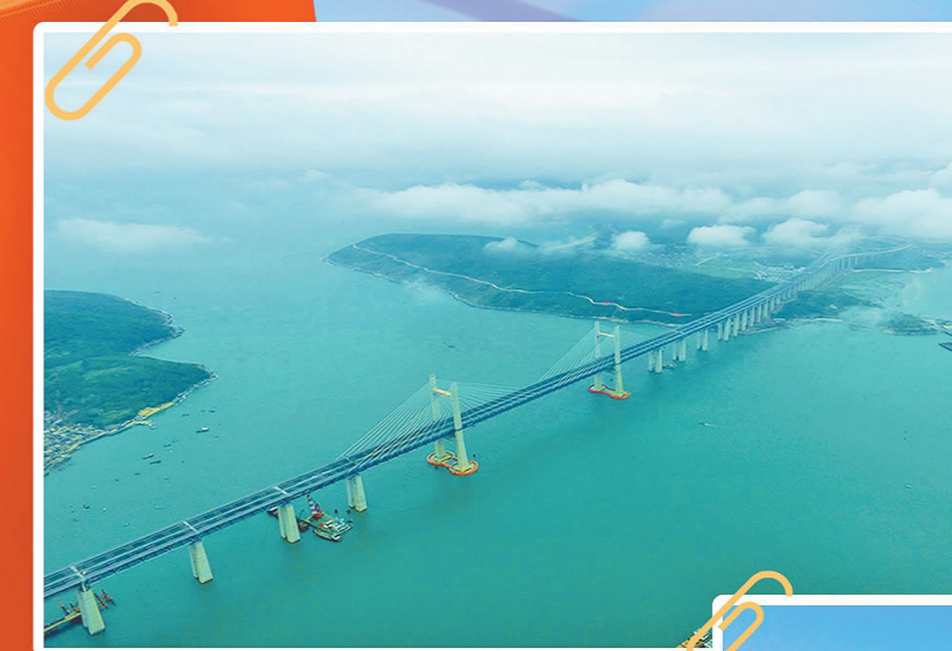
2020年12月26日,由中国铁建大桥局承建的中国首座公铁两用跨海大桥——福平铁路平潭海峡公铁两用大桥建成通车。该桥全长16.34公里,更新建福州至平潭铁路、长乐至平潭高速公路的关键性控制工程,也是截至目前世界在建难度最大的跨海大桥。 李 冰 摄
