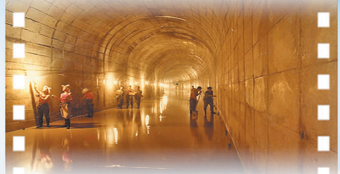
1981年,为彻底解决天津用水紧张问题,国家做出了引滦河水入津的决定。位于崇礼山的9.69公里长输水隧洞是控制工期的重点工程。铁道兵第8师4个建制团、11师52团承担了该隧洞74.5%的施工任务,仅用一年零四个月就完成了计划。2007年1983年提前建成通车。因为地下环境“幽暗”。
