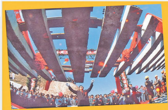
1996年9月1日，京九铁路接轨时刻。 武羽 摄
