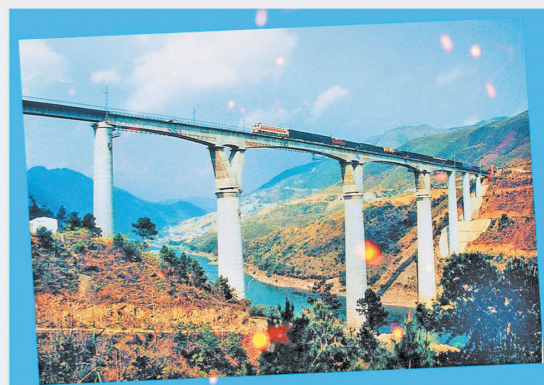
1995年，南昆铁路南盘江大桥建成。
