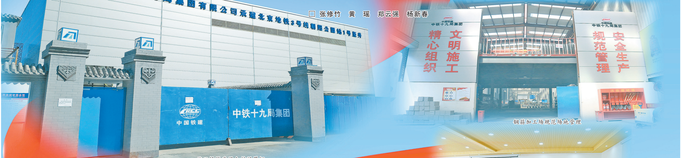
施工场区采用全封闭围棚
