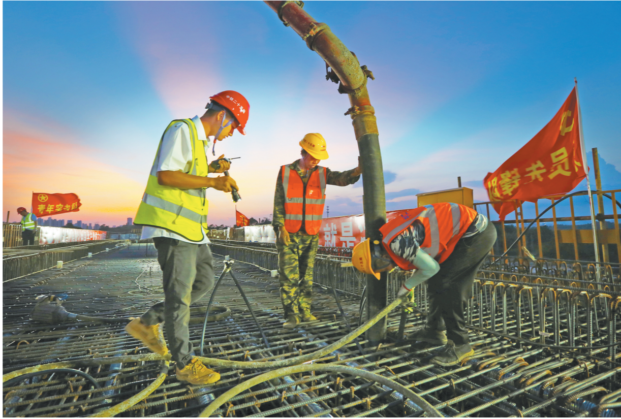
6月以来,中铁二十五局四公司南玉铁路项目部掀起施工大干高潮,提前编制安全专项方案,采用“专职安全员+智能监控设备”盯防重点区域,确保南玉铁路全线首联连续梁混凝土浇筑。图为专职安全员全程盯控连续梁混凝土浇筑。周群能 摄
