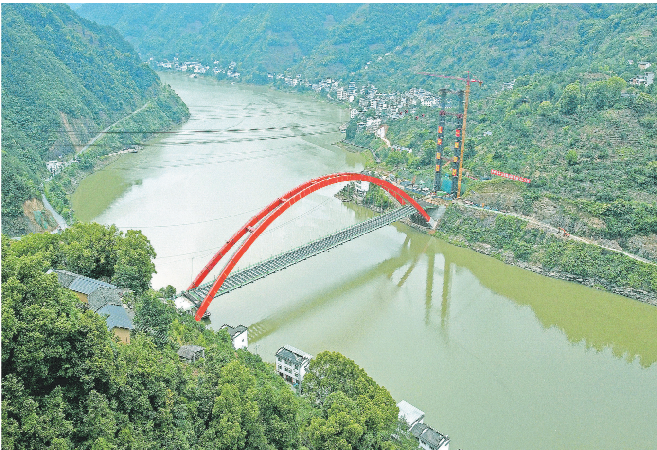
日前,中铁十五局三公司承建的安徽省在建最大单拱大跨径中承式钢箱提篮拱桥——歙县新安江大桥桥面钢主梁吊装完成,为桥面铺设创造了条件。新安江大桥全长277米,桥面宽12米,通过水上转体和高空塔索起吊方式在空中完成“拼图式”合龙。该桥建成后,将结束两岸10万群众摆渡过河的历史,对方便百姓出行和促进当地经济发展具有重要意义。图为完成桥面钢主梁吊装的新安江大桥。冯 磊 摄
