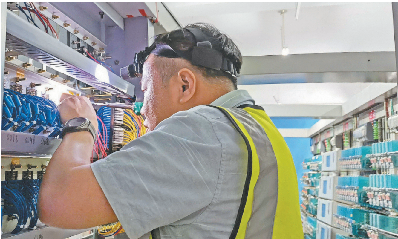
5月30日凌晨3时,经中铁二十三局电务公司建设者连续奋战,滨北绥佳铁路区间逻辑检查功能建设施工顺利完成,线路正式开通运营。此次施工的顺利完成,为滨北绥佳铁路既有列车安全运行奠定了基础。图为施工单位人员在施工封锁期间进行车站信号机械室组合架架线施工。
