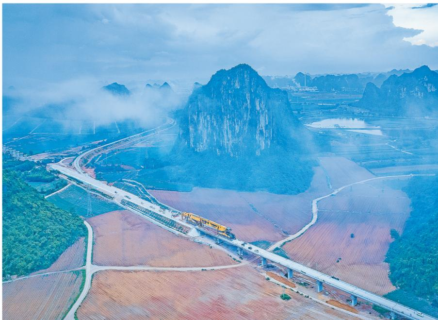
5月28日,由中铁十一局承建的南崇铁路5标率先在全线贯通。南宁至崇左高速铁路是第一条广西自主投资建设的高速铁路,设计时速250公里,建成后,线路西端经湘桂线与越南的同登至河内铁路相连,经河内与万象、曼谷、吉隆坡、新加坡相通,形成中国与东盟半岛的交通大动脉。图为最后一节箱梁架设现场。 杨光 摄
