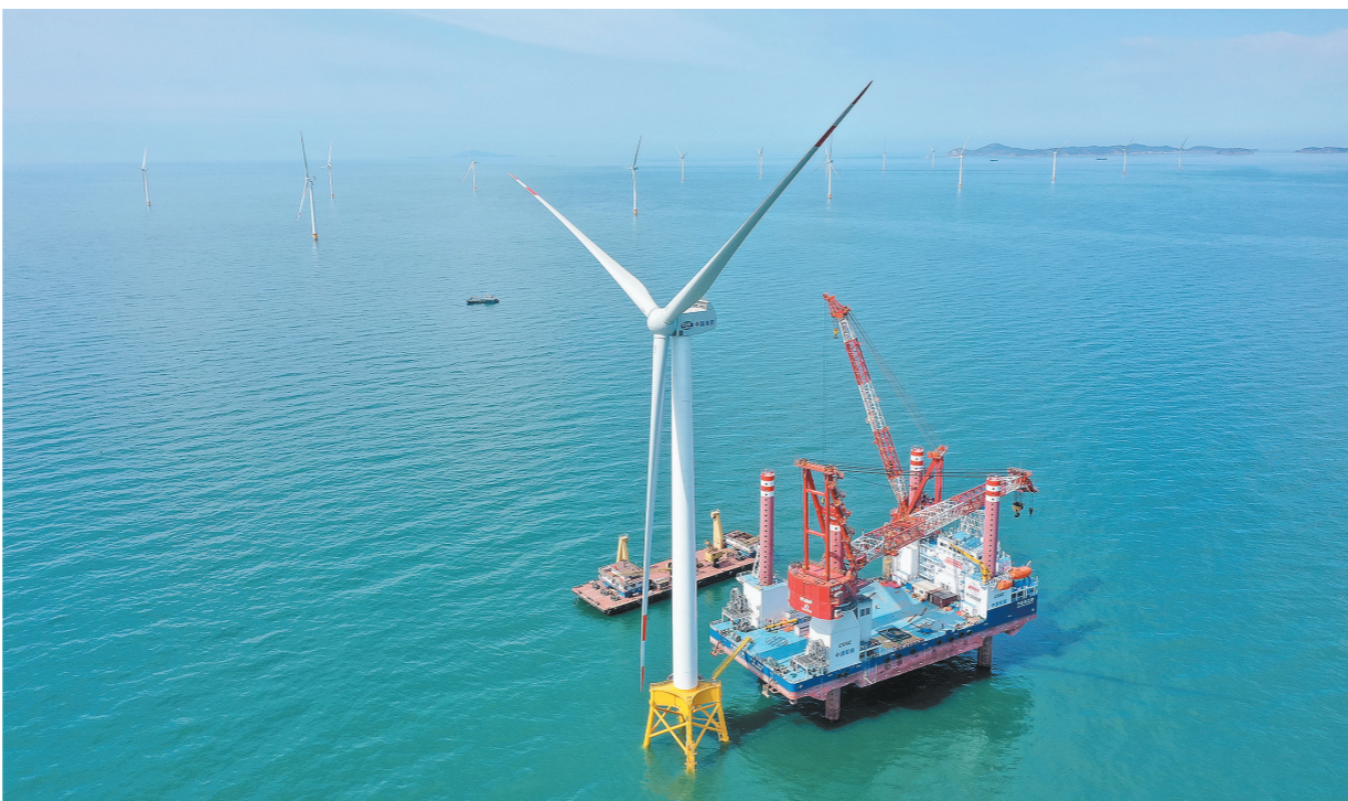
日前,由中国铁建港航局承建的大连庄河海上风电项目顺利完成首台吸力筒基础风机安装,填补了中国铁建吸力筒基础风机安装的技术空白。据悉,该项目的建成将加快推进辽宁“百万千瓦级”海上风电基地建设,为实现我国“碳达峰”“碳中和”目标作出积极贡献。图为首台吸力筒基础海上风机吊装完成。李国桦摄
