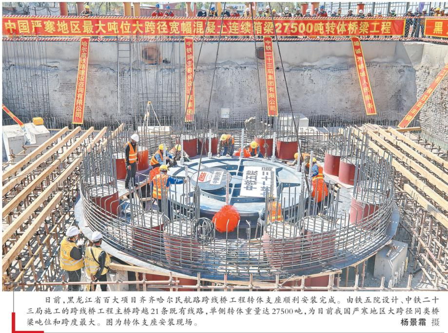
日前，黑龙江省百大项目齐齐哈尔民航跨路桥梁工程转体支座顺利安装完成。由铁五院设计、中铁二十三局施工的跨路桥梁工程主桥跨越21条既有线路，单侧转体重量达27500吨，为我国严寒地区大跨径同类型桥梁吨位和跨度最大。图为转体支座安装现场。 杨霖雷 摄
