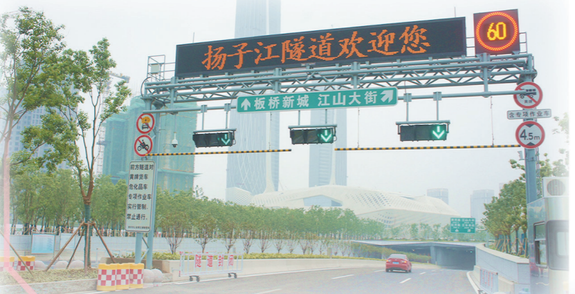
全国投资规模最大的城市轨道交通枢纽之一——南京青奥轴线下工程
