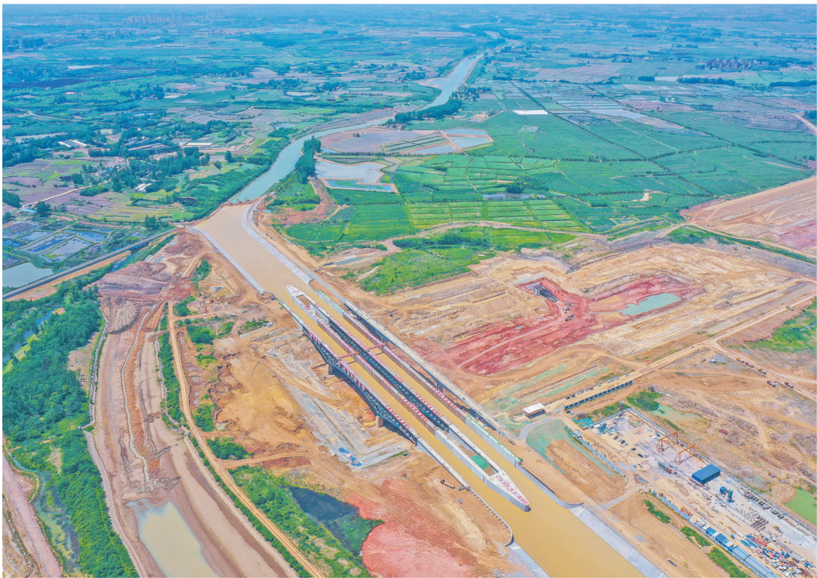
日前,由中国铁建大桥局承建的引济济淮黄河总干渠渡槽充水试验成功。济河总干渠主跨110米,凌空30多米横跨引济济淮主河道,超过著名的德国马格斯塔堡水桥登顶主跨世界第一。该工程总用钢量达2.1万吨,安装精度、焊接质量世界领先,可承水近4万吨,承载力相当于135个车道或25线轨道的高铁同时运营,建成后极大改善皖北和豫东水资源紧缺状况。图为济河总干渠渡槽正式通水。李天玉 摄
