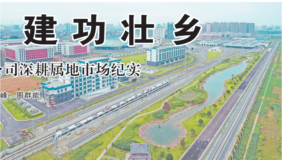
图为全国首个海绵车辆段——南宁地铁3号线心圩车辆段。 钟咏峰 摄
