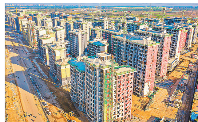
由中铁建设承建的容东片区D1组团安置房,是中国铁建在雄安新区合同额最大的安置房项目,项目团队践行“四铁四心”,落实“两抓五保”,质量、安全、进度稳步推进。图为4月30日,D1组团外立面陆续亮相。贾旭辉 摄
