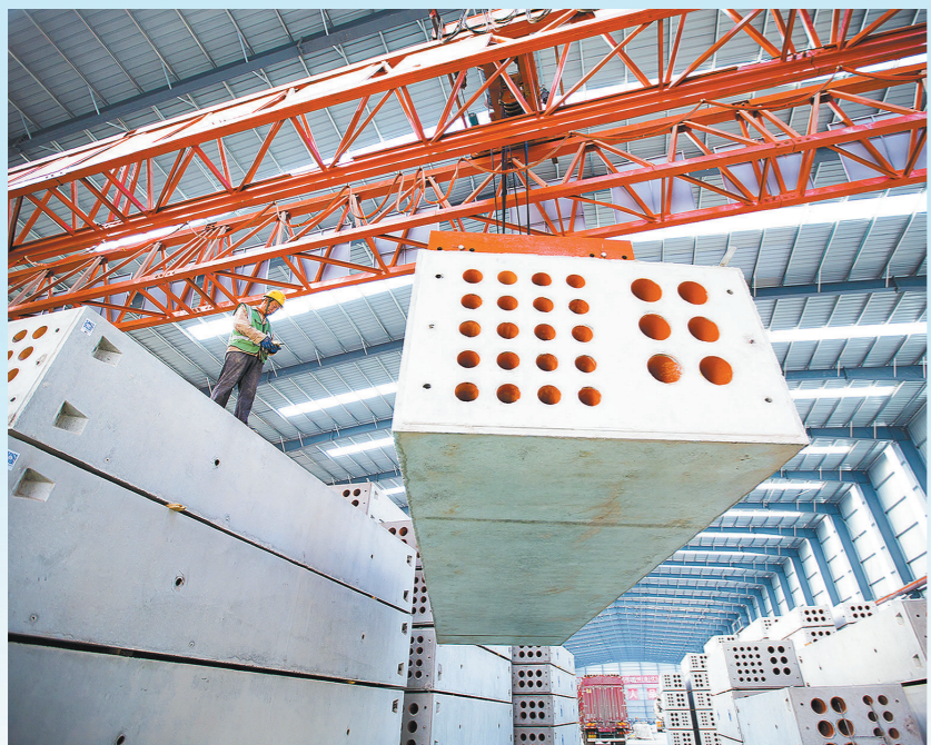
中铁十一局顺利完成雄安新区容东DEG社区内3632节组合管排预制任务。图为4月24日,建设者正在进行组合管排吊装。金伟 摄
