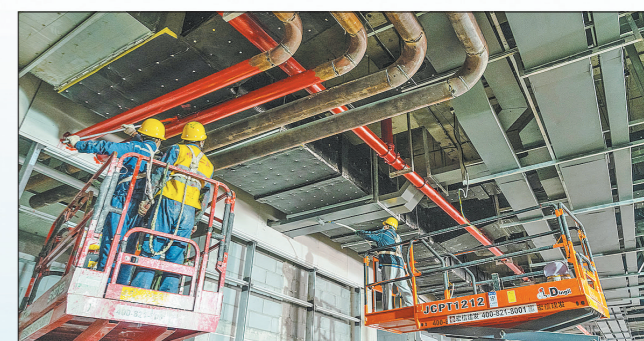
由中铁十二局施工的新月公园形似月亮,设计为绿色生态公共空间,与雄安站站前广场和地下商业空间浑然一体,凸显站城一体、多维景观理念。该项目占地6.78公顷,建设者精心组织施工,创造不到一月建成一座公园的雄安速度。图为4月22日,建设者正在进行地下层设备安装。段继新 摄
