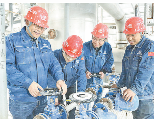
图为杨富山(左一)在现场调试仪器。
