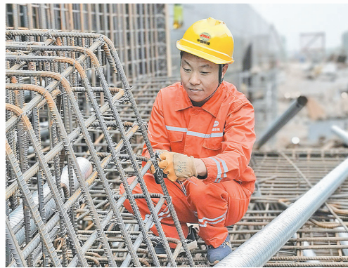
图为朱益龙在现场绑扎钢筋。
