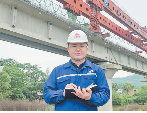
图为宋君在桥梁架梁施工现场记录施工情况。
