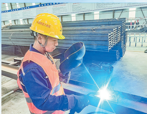
图为许付贵焊接工字钢。
