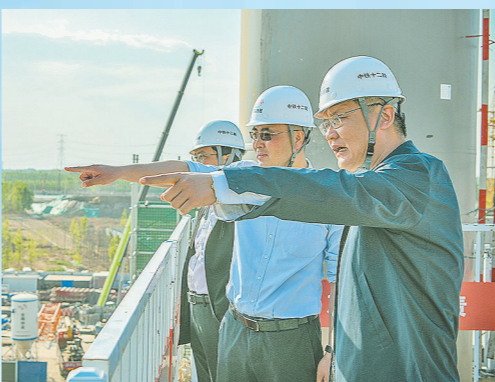
图为曹太然(右)在雄安站房施工现场与管理商讨方案。
