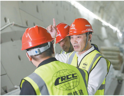
图为张成在现场检查施工进度情况。
