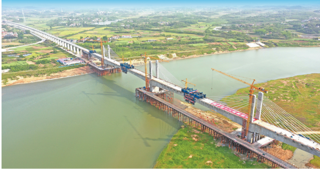
4月18日,由铁四院设计、中铁十六局承建的黄(冈)黄(梅)铁路巴河特大桥主桥安全顺利合龙,标志着黄黄铁路进入无砟轨道施工阶段。巴河特大桥设计时速350公里,全长约2961米,是全线重点控制性工程之一,也是目前国内高速铁路首座三塔部分斜拉桥工程。主要施工中,建设者采用8米大节段悬臂造桥机。该造桥机的使用开了国内高速铁路建设先河,节省有效工期4个月。图为主桥合龙后的巴河特大桥。 许鹏健 摄
