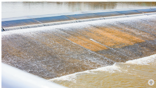
①该项目液压坝坝对泔河治理的方法、平原区砂质河道综合治理方法已申请专利发明,为新业态流域治理发展打开局面,积累了丰富的河道施工经验。图为已经投入使用的液压坝。
