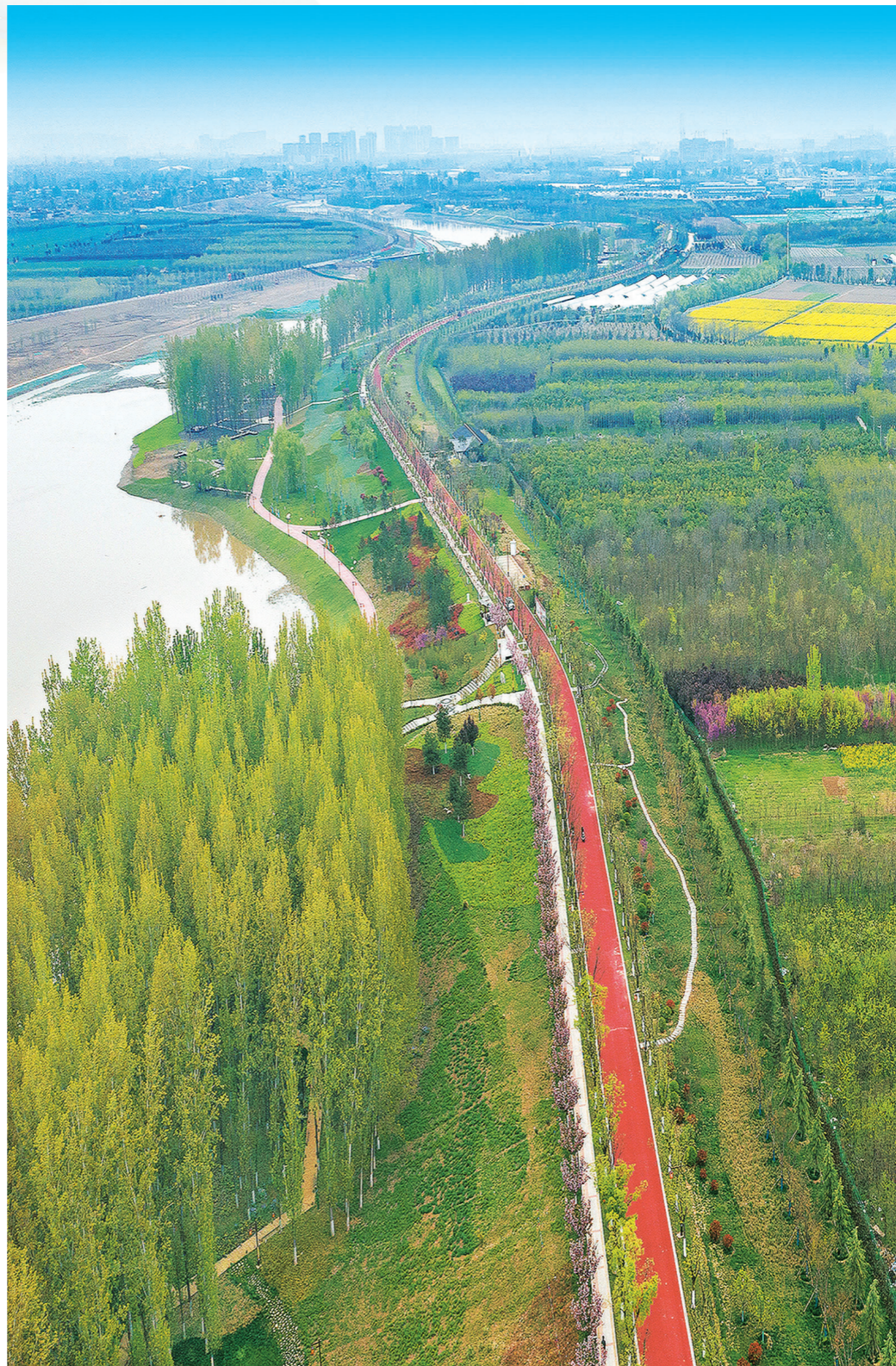
图为航拍陕西西安泔河综合治理二期工程。
