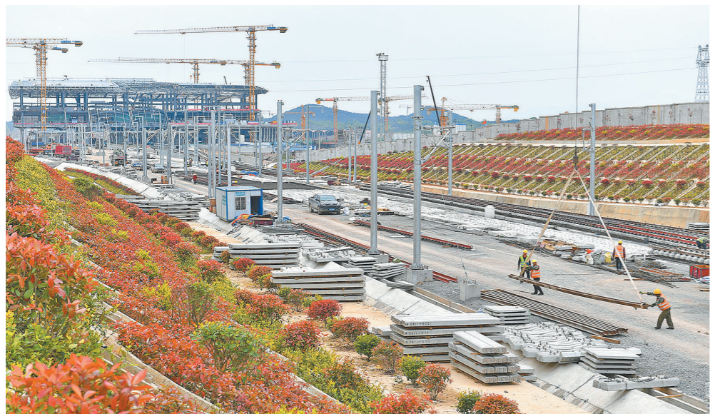
“环境就是民生,青山就是美丽,蓝天也是幸福。”安九项目通过四年多的绿色施工实践,获得安徽省“AAA级环保施工示范工地”殊荣。图为4月6日,正在施工的安九项目一标施工现场。
