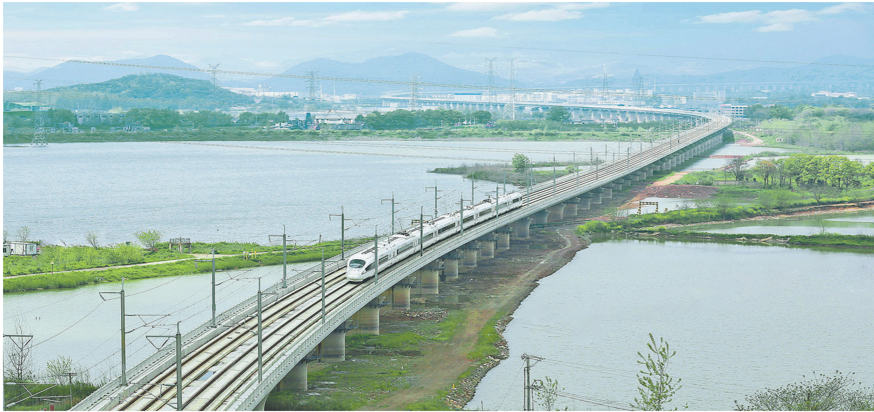
中铁十七局承建的安九高铁,地处安徽省安庆市境内,紧邻长江干线十大港口之一的安庆港,位于多条流入长江流域的水源施工,主要包括龙山隧道等3座隧道、石门湖特大桥等18座桥梁,总长38公里。图为4月8日,高铁通过石门湖特大桥。
