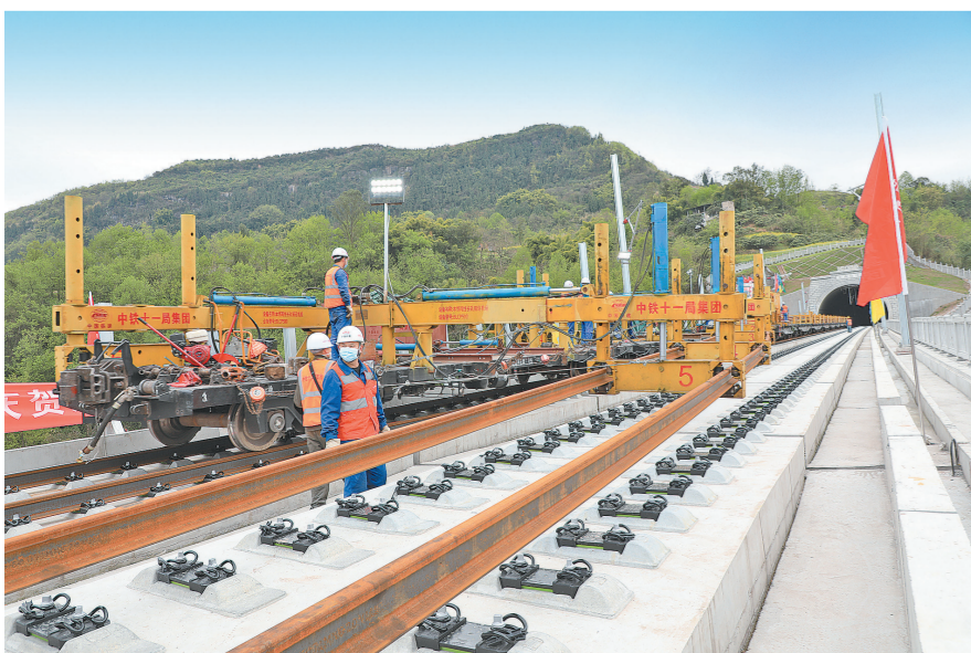
图为3月17日,机组在进行跨线铺轨作业。刘连强 摄
