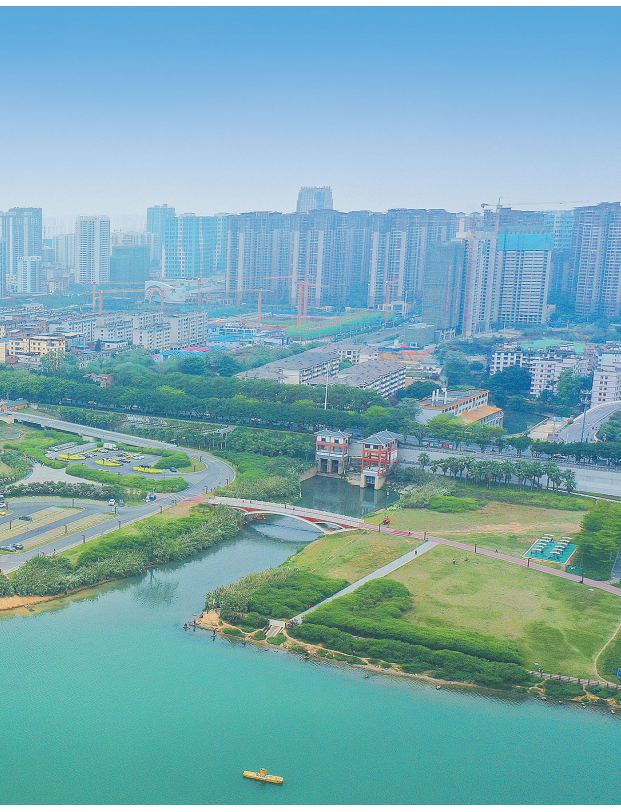
3月15日,由中铁十一局二公司承建的南宁亭子冲流域治理工程竣工。该工程通过河道两岸截污治污,改善内河水质,消除黑臭状态,使亭子冲成为一条具有防洪、生态、景观、文化等功能的健康河道。图为治理后的亭子冲邕江出水口段。 赵 能 摄
