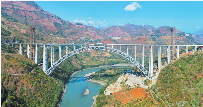
由中铁十八局负责施工的世界最大跨度铁路拱桥——大瑞铁路怒江特大桥施工建设,截止目前已完成全部工程量的95%,预计今年年底完成全部施工任务。图为3月5日,正在进行桥面系施工的大桥全景。 周俊 摄
