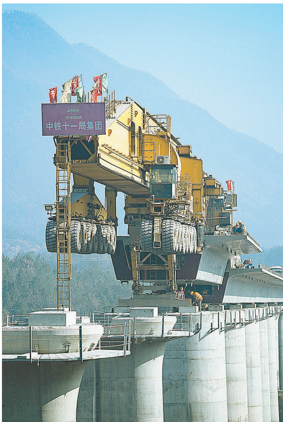
中铁十一局汉江重工研制的全国首台900吨运架一体机在广汕高铁惠东段进行铺架施工,该设备能够重载900吨高铁箱梁在隧道内便捷穿梭,特别适用于我国中西部及隧道群较多地带高铁建设。 杨光 摄
