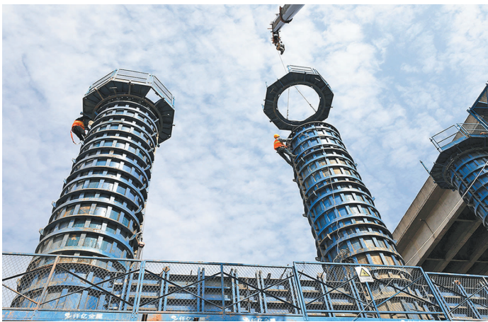
由中铁二十三局负责施工的成绵苍巴高速公路工程线路总长度约158.3公里。作为四川省重点公路工程,在“十四五”开局之年,项目现在已完成全部临建工程,正式进入施工大干阶段。图为3月1日,建设者正在涪江特大桥进行墩柱模板组拼及操作平台吊装作业。 马鹏飞 摄
