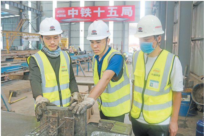
由中铁十五局负责施工的中老铁路磨丁——万象段801257根桩枕和248组岔枕预制任务,截止2月底已完成97%,预计3月25日前完成全部施工任务。图为技术人员指导老挝籍员工进行穿丝作业。 李祖礼 摄
