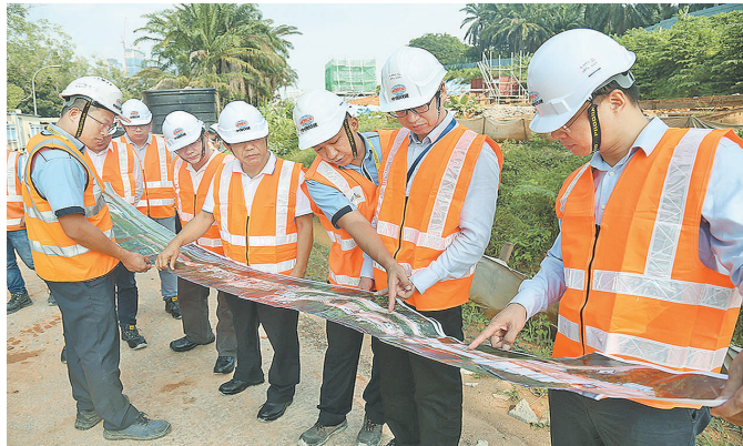
进入2021年以来,中国铁建国际集团克服疫情影响,推进境外重点项目全面复工。其中,马来西亚金新铁路项目第三工区正进行大规模铺轨。图为3月2日,建设者在现场研究施工方案。 姚景峰 摄
