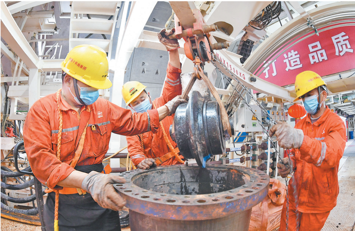
连日来,中铁十四局大盾构公司南京和燕路过江隧道工程抢抓春光,施工跑出“加速度”,开挖直径15.07米的“复兴号”盾构机已掘进至第1139环,穿越了长江、进入幕府山底,在岩溶地层平稳掘进;常压换滚刀技术也取得重要实践突破,6名工人两天时间可换刀19把,大大提高了施工效率和安全性。 刘福昌 摄
