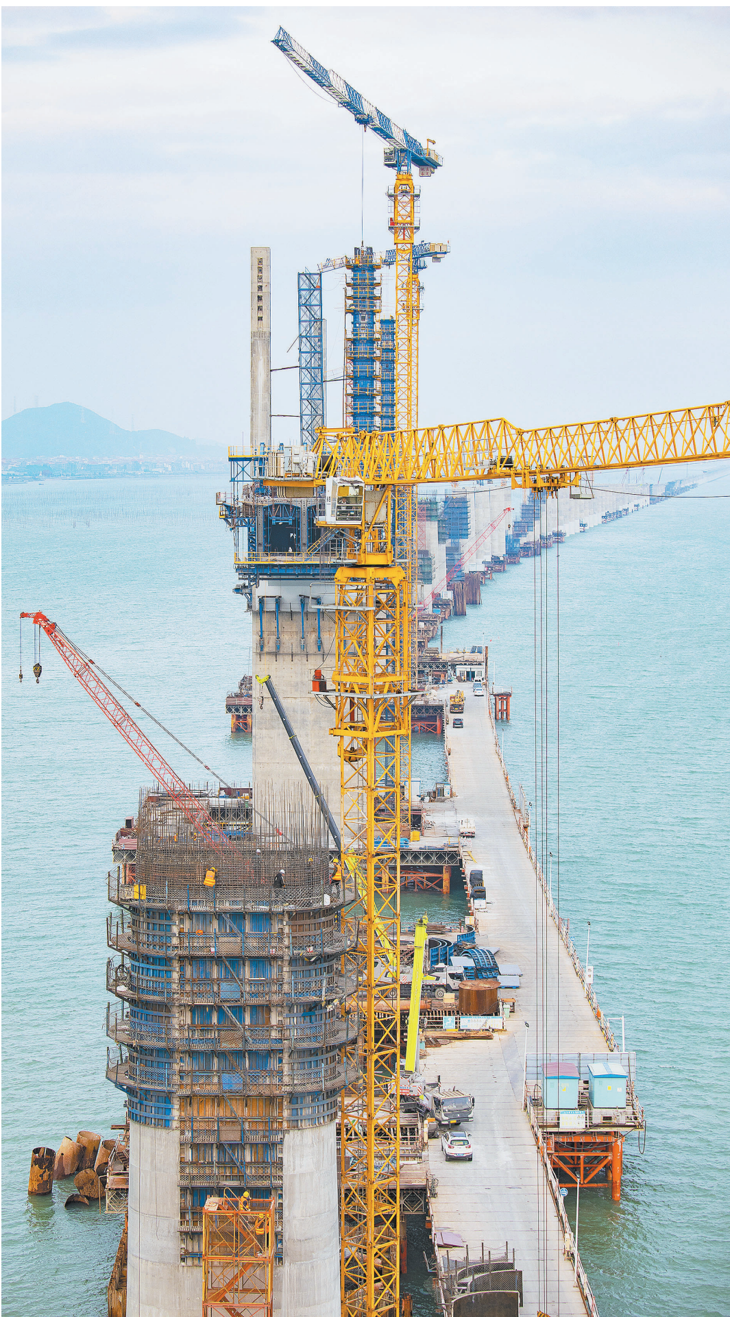
中铁十一局承建的福厦高铁湄洲湾跨海大桥全长14.7公里,主桥为预应力混凝土连续刚构矮塔斜拉桥,主跨180米,跨越湄洲湾规划3000吨级航道,是国内首座跨海高速铁路矮塔斜拉桥,预计3月15日开始斜拉索挂索施工。图为建设者正在进行海上桥梁施工。 金伟 摄
