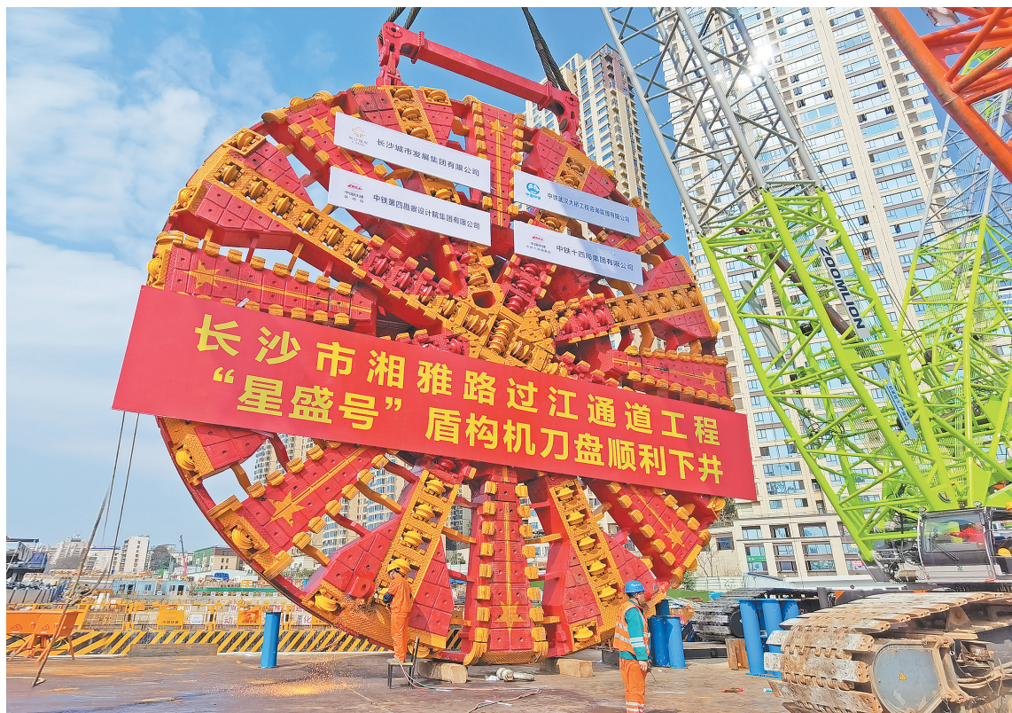
近日,由中铁十四局大盾构公司和铁建重工联合打造的“星盛号”盾构机,在湖南省重大民生工程长沙湘雅路过江隧道现场下井组装。该盾构机刀盘直径15.01米,是第一台穿越湘江的最大直径泥水平衡盾构机。图为“星盛号”盾构机刀盘吊装下井。丁甜摄
