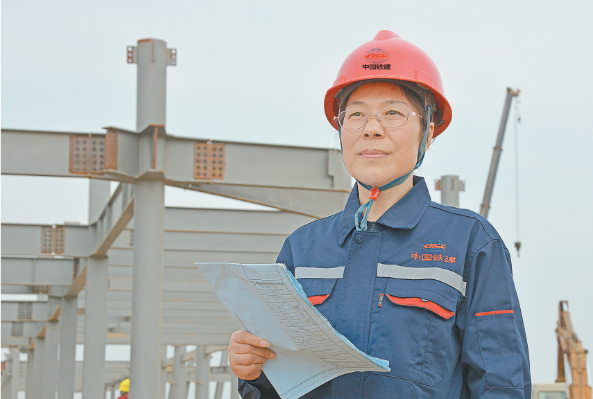
崔志玉在中国商飞江西生产试飞中心项目施工现场指导钢结构安装。张 伊 摄
