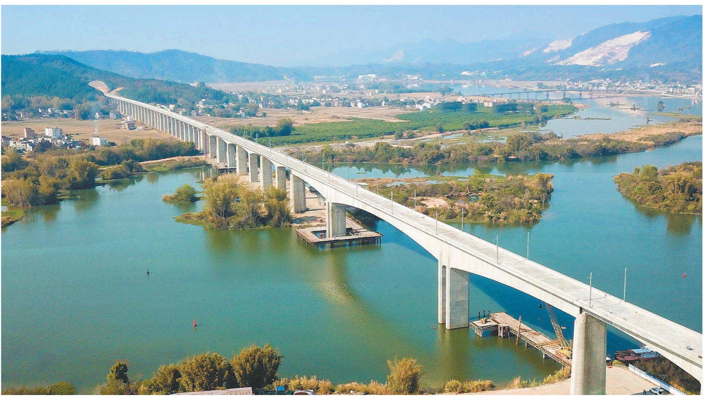
2月22日上午10时18分,由中铁二十五局参建的赣深高铁河源段箱梁架设全部完成,标志着这项粤港澳大湾区互联互通轨道交通重点工程取得重大突破。春节期间,项目建设者坚守一线,圆满完成了591根箱梁架设任务,为今年年底全线建成通车奠定了坚实基础。图为完成架梁的赣深高铁河源段柳城江特大桥。黄诗伟 摄
