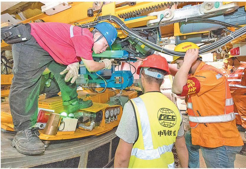
春节期间,正值华南建设广州地铁18号线和22号线首通段最后攻坚的关键时期,中国铁建5000多名施工人员在岗坚守,保证了全线土建、机电、轨道和车站装修等各项工程的进度。图为施工人员在现场协商联络通道冷冻法施工技术处理。段绪江 摄
