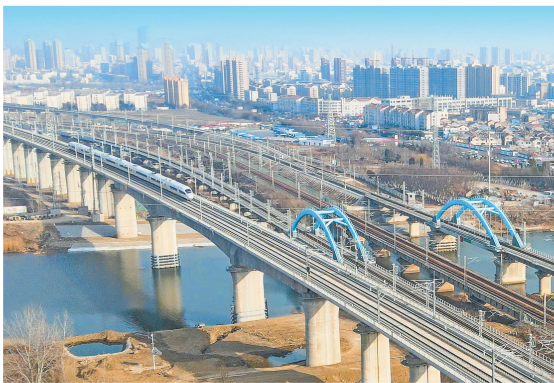
图为列车飞驰在徐连高铁连云港特大桥上。
