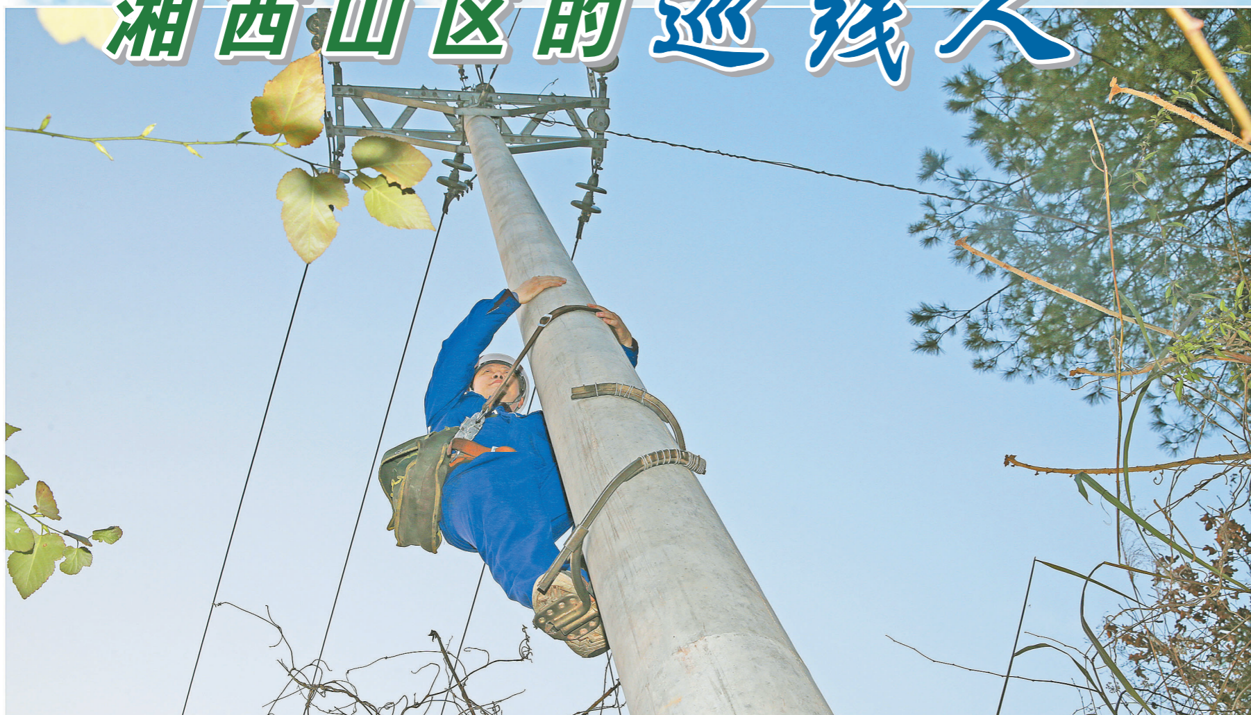
长达60余公里的电力线路绵延在深山中,巡线员们沿线进行巡视,时不时爬到电线杆上,对电力设备进行检测维修。图为上午10点40分,张学年踩着脚扣上电线杆仔细查看。
