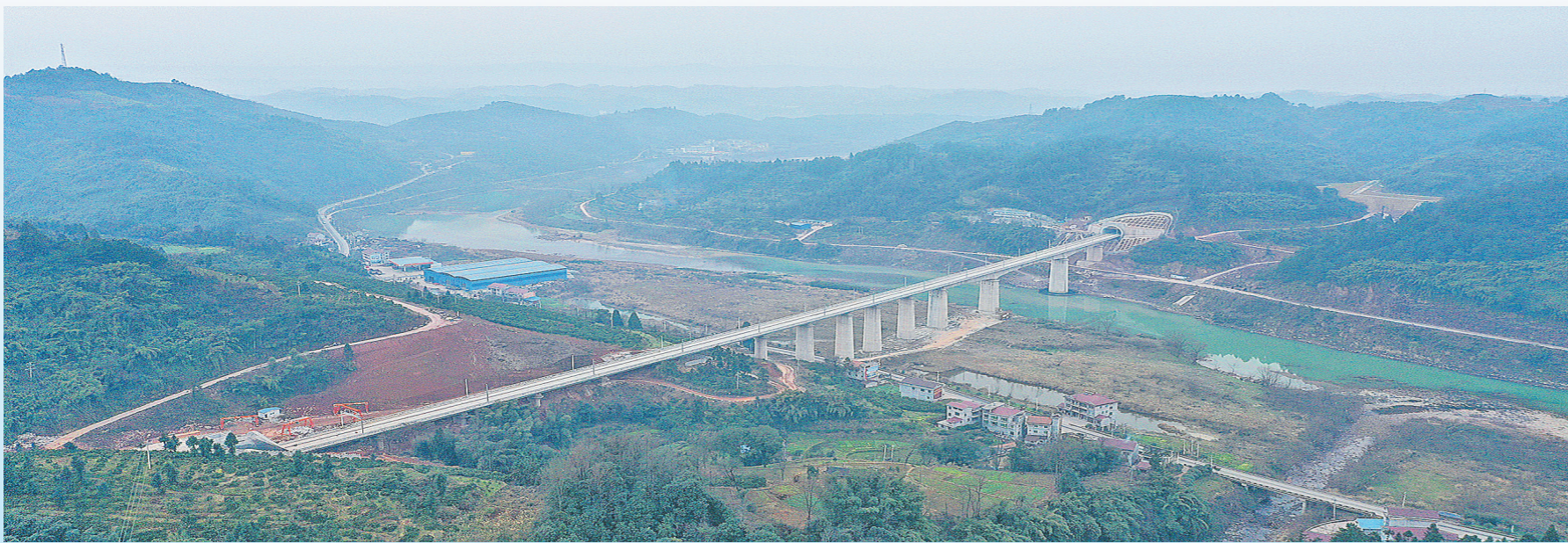
张吉怀高铁连接张家界、凤凰古城等著名风景旅游区,沿线风光秀丽,森林公园、自然保护区分布范围广,全线桥梁隧道比例高达91.3%。图为张吉怀高铁锦江特大桥。
