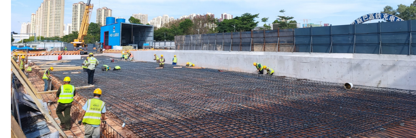
日前，中铁十九局轨道交通深圳地铁16号线五区项目三站三区间主体结构在全线率先完工。
