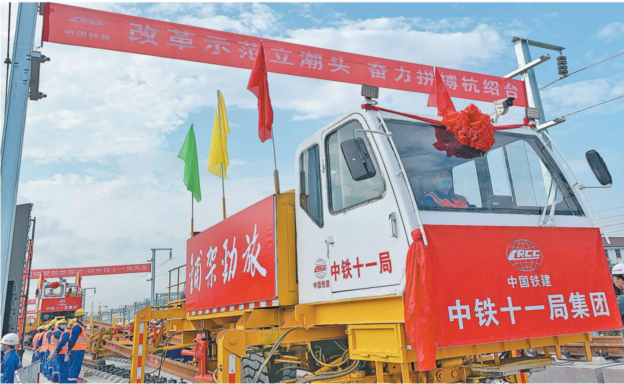
2月1日,由中铁十一局参建的我国首条民营控股高铁杭绍台铁路开始全线铺轨。建设者采用“WZ500铺轨机拖挂法”进行铺轨作业,铺轨速度快,安全性能高。该线建成运营后,杭州与台州之间出行时间将由2小时左右压缩至1小时左右,对构建浙江省内“1小时交通圈”、助力长三角地区更高质量一体化发展具有重要意义。图为施工人员进行铺轨作业
