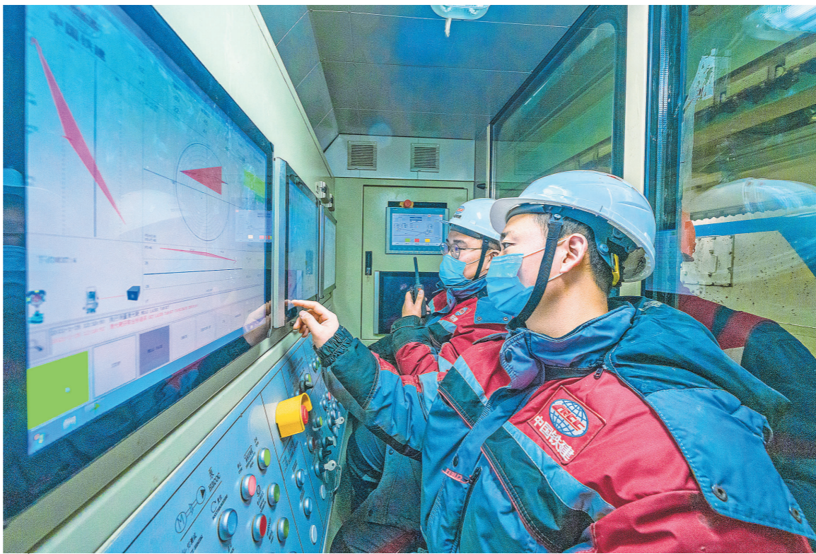
1月25日,由中国铁建自主研发生产的叶甫盖妮娅号盾构机在莫斯科地铁西南线项目始发。该盾构机是为适应俄罗斯严寒气候而专门研发的,可在莫斯科零下30摄氏度的极端天气中顺利完成掘进任务。图为盾构机司机操作叶甫盖妮娅号掘进。李琳佳 摄
