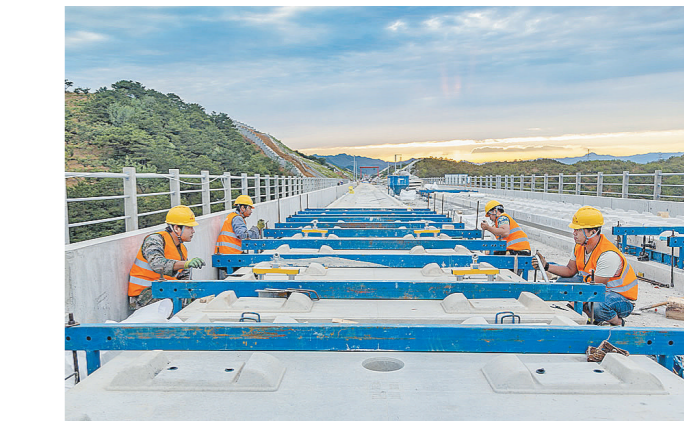
工人进行轨道板精调作业。 侯钦佩摄
