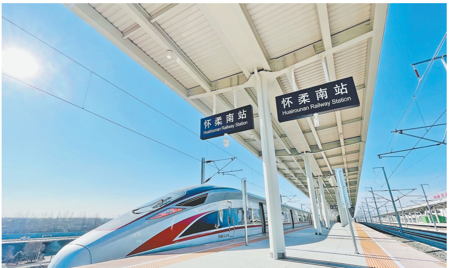
近日,由中国铁建承建的京哈高铁沈段北京朝阳站、顺义西站、怀柔南站、密云站顺利通过开通前的安全评估工作,目前正在与运营单位进行交接。据悉,京哈高铁是我国“十四五”开通的首条铁路。图为“高寒版复兴号”抵达怀柔南站站台。
