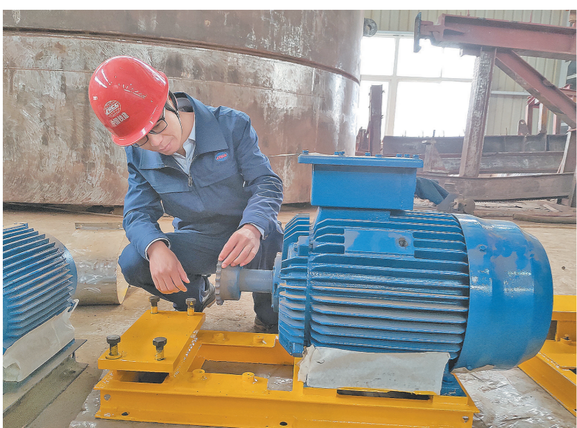
图为郭寅圣正在抽检液压机联轴器磨损情况。
