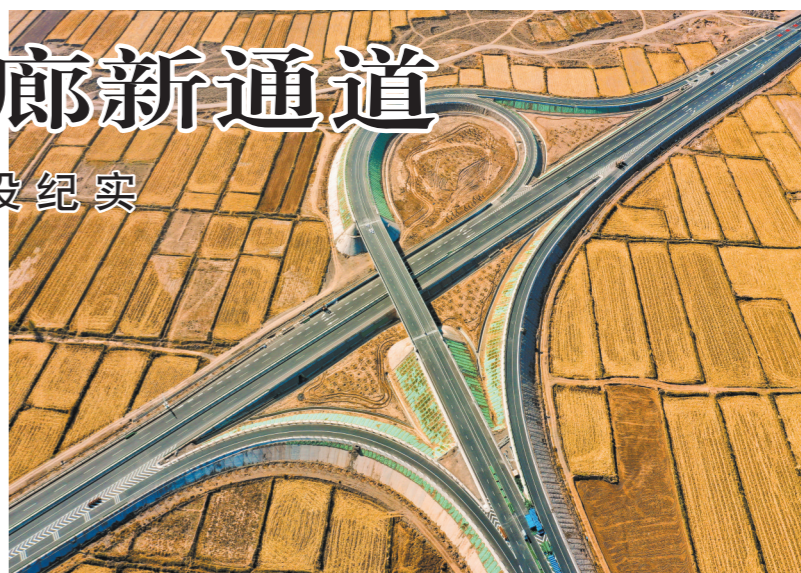
图为张扁高速公路六坝互通立交。 赵 森 摄
