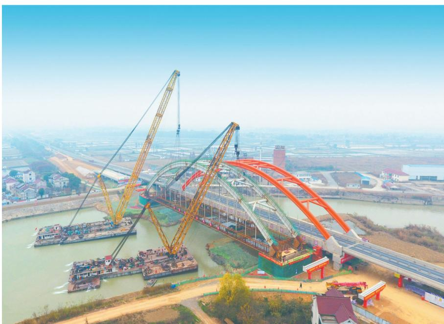
12月18日,由中铁二十局一公司承建的安徽芜湖至上海(芜中线)航道整治工程重点控制性项目——位于江苏省常州市的河定大桥正式合龙。河定大桥拱桥桥架结构重638吨、长126.18米,施工过程中采用整体吊装工艺,使工期缩短一年时间,为国内建设同类桥梁提供了宝贵经验。图为浮吊船吊装河定大桥拱桥桥架结构现场。杨青妹 摄
