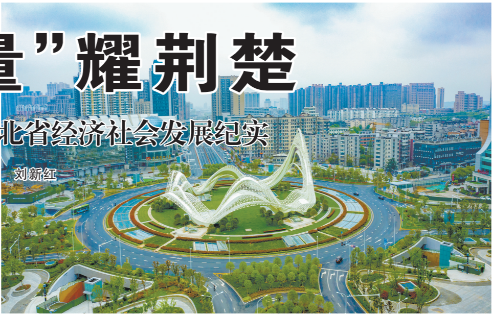
图为中铁十一局参建的亚洲规模最大城市综合体武汉光谷广场。 金伟摄
