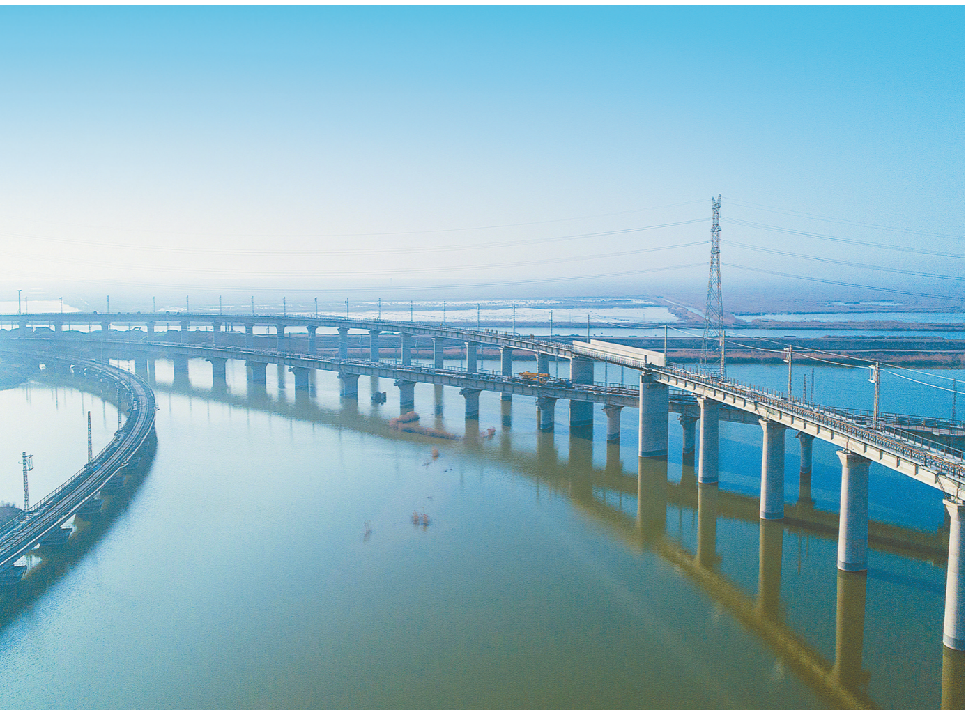
日前,中铁十二局参建的天津南港铁路开通运营。建设者克服既有铁路线运输干扰、穿越池塘软泥地层和水中墩墩等施工难题,破解净空架梁施工难题,取得了20余项科研成果和新型专利技术成果。图为天津南港铁路万万上联大桥。 陈朝辉 摄
