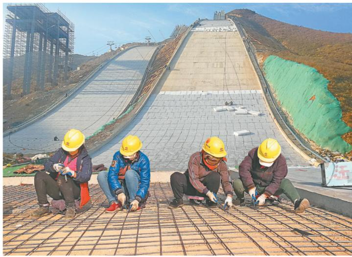
图为日前,施工人员进行滑雪跳台停止区混凝土钢筋网绑扎作业。 黄艳艳 摄
