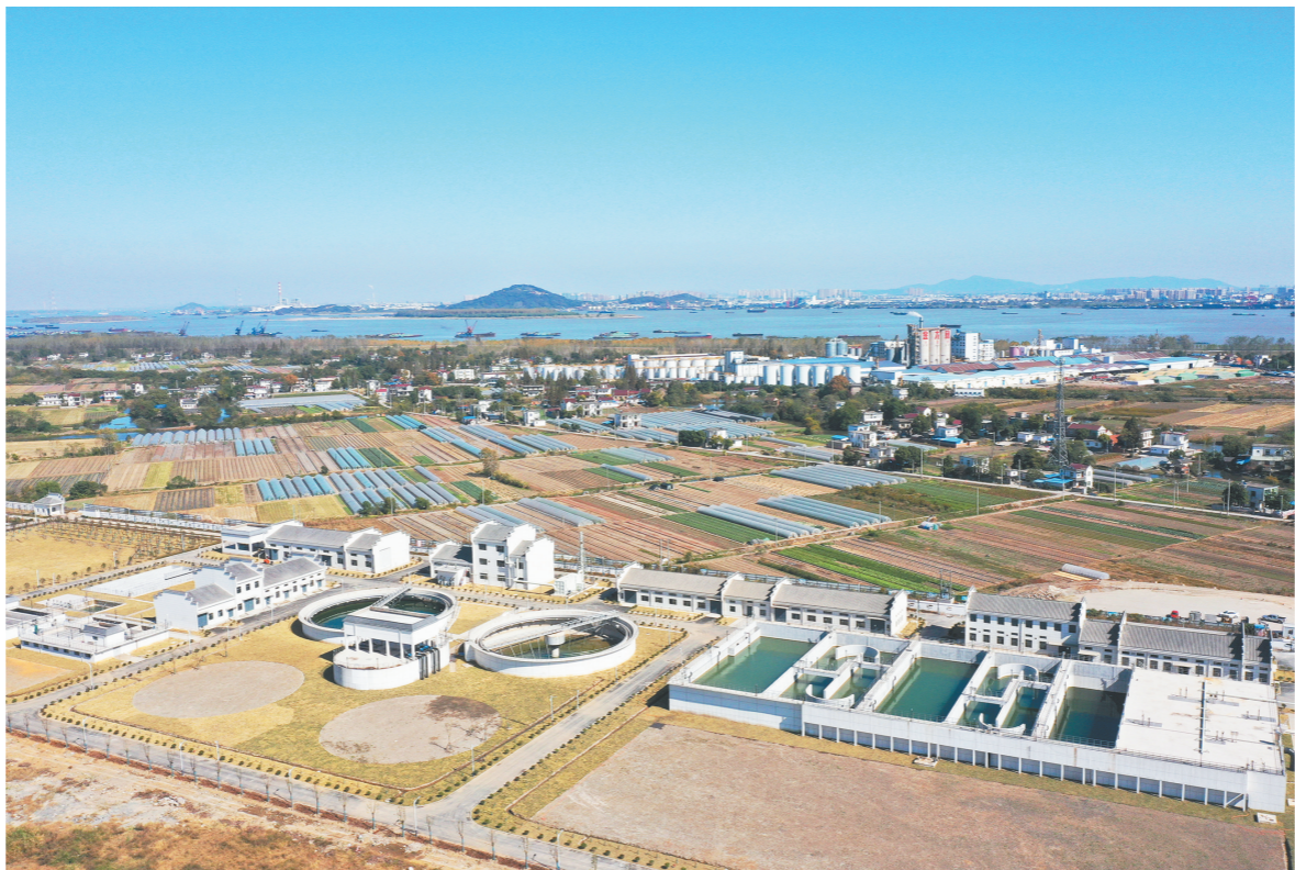
日前,中国铁建参与的首个长江大保护项目——安徽芜湖大龙湾污水处理厂顺利通过工程主体和设备安装验收,厂区正式投用进入倒计时。水厂采用先进的污水处理工艺改良AAO系统和生物除臭系统,经过多层过滤及处理,将有效减轻污水直排长江造成的污染。图为中铁十四局二公司承建的芜湖大龙湾污水处理厂。 王观生 摄
