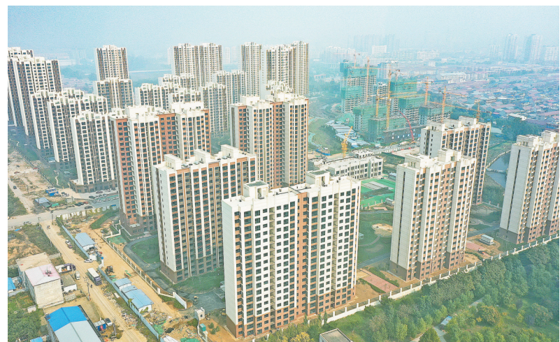
图为中铁十八局建安公司承建的遵化市首个装配式棚改项目——遵化市棚改回迁安置房项目。 胡杨摄
