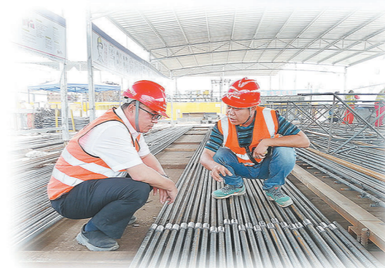
项目经理李健学(左一)检查机械连接件施工质量
