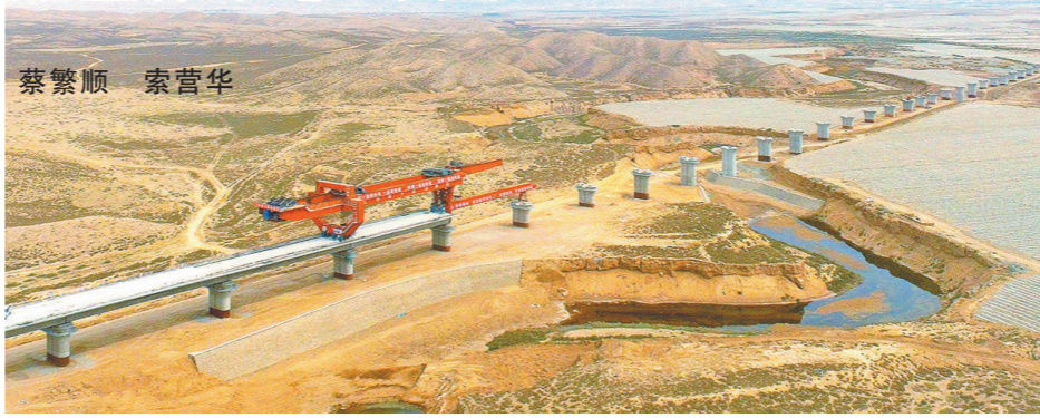
中铁十四局建设者通过实时监测运梁车轮胎的胎压等措施,攻克了下坡架梁难题,在全线率先完成箱梁架梁任务。图为他们在架设米粮川特大桥。索营华 摄
