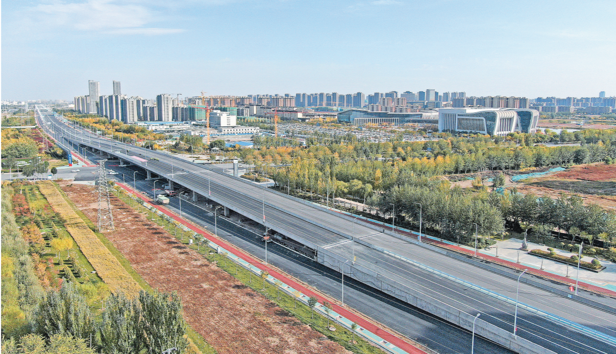
10月20日,由中铁建西北投资建设公司投资、中铁二十一局等单位承建的银川市首条贯穿东西的城市快速道路——沈阳路快速通道工程全线顺利贯通。该项目全长21.88公里,对促进银川都市圈经济社会发展具有重要意义。图为沈阳路快速通道。张院生 摄
