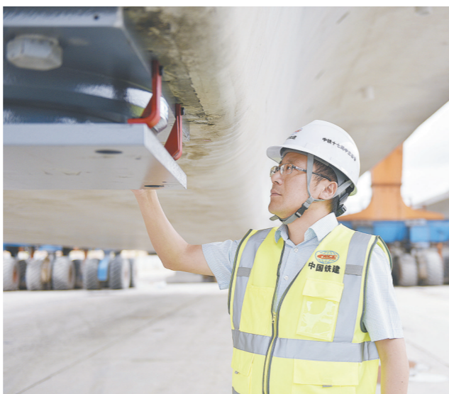
图为袁川贵在检查箱梁支座安装质量。 段文婷 摄
