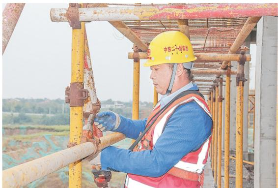
图为架子工兰祖金在复检加固脚手架。杨曼平 摄
