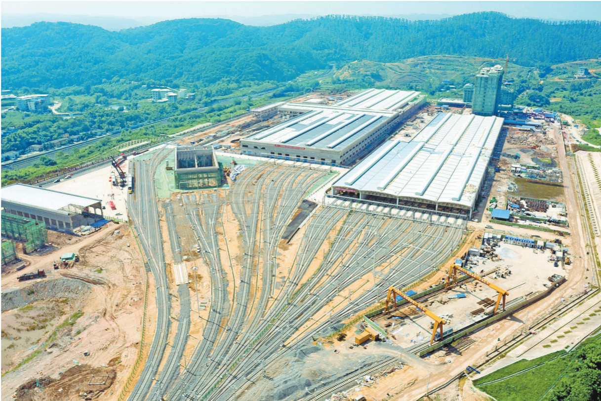
近日，由中铁十八局参建的广西南宁轨道交通五号线全自动地铁车辆基地建成投入使用。该基地总建筑面积二十多万平方米，共设五十一条轨道、四十个停车位，能够承担二十多列无人驾驶列车的调试、检查、运行维护等任务。图为南宁轨道交通五号线车辆基地。
