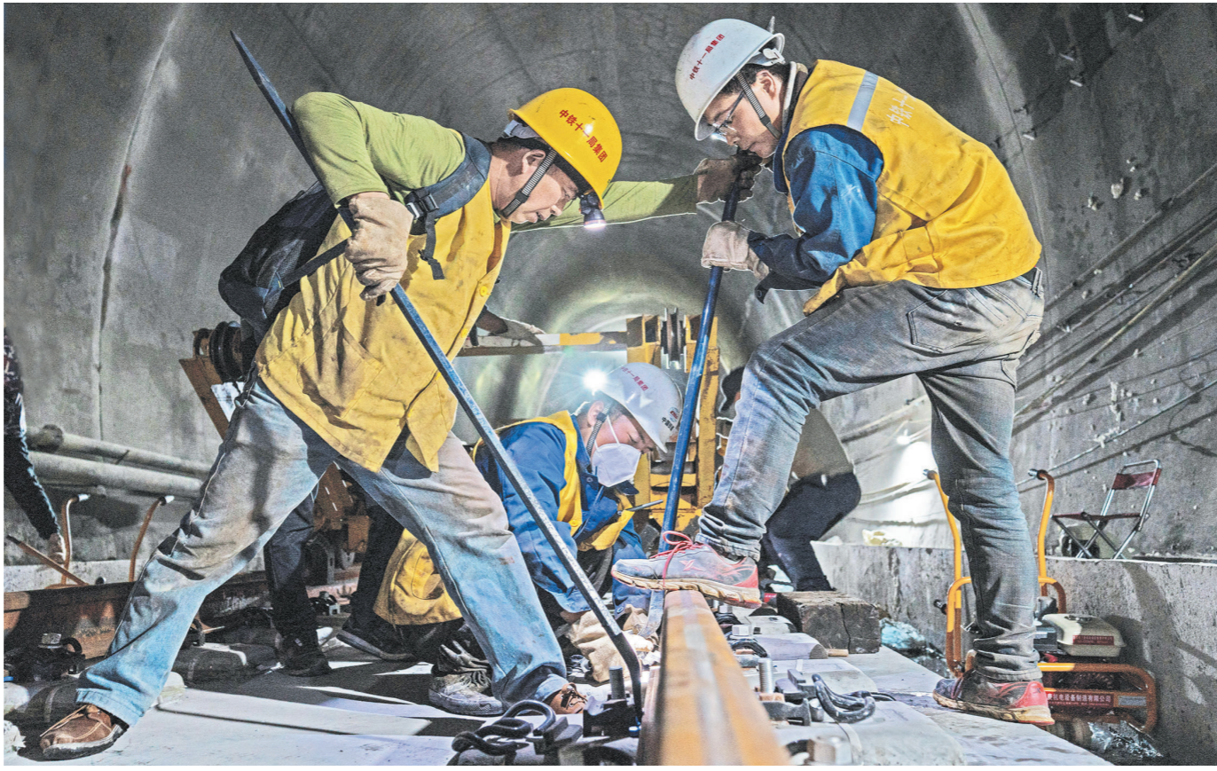
8月26日,在拉林铁路拉隆隧道出入口处,随着中铁十一局三公司建设者将一组500米长钢轨顺利铺设在无缝道床上,标志着因疫情影响的拉林铁路全线铺轨施工正式恢复,进入攻坚阶段。拉林铁路新建正线全长399.61公里,已经完成铺轨施工总任务的31%,预计2021年全线通车。图为建设者正在调整轨距。 丁庆滨 摄
