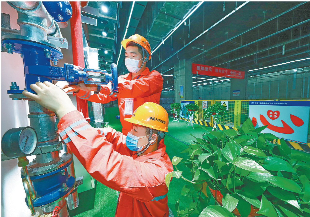
为维护一线工人身体健康,中铁十四局电气化公司常州地铁项目将地上“办公室”工作环境标准搬到了施工现场。在地下15米的施工场地,他们定期更换铺设的绿地毯,摆放大量绿植,每隔10米就设置雾炮机进行除尘,工人还可以直观地在检测设备上查看空气质量指标,一流的地铁绿色施工环境让项目在文明工地评比中获得“春风行动”等各种奖章。图为技术人员在优良的地下工作环境中施工。范成涛 摄
